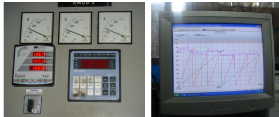
รูปที่ 4.26 การติดตั้งระบบบริหารจัดการพลังงาน และควบคุมการใช้ไฟฟ้า
