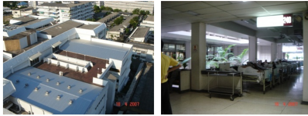
รูปที่ 4.16 แสดงการเปิดช่องโถงภายในอาคารเพื่อนำแสงธรรมชาติเข้ามาใช้อย่างมีประสิทธิภาพในอาคาร
