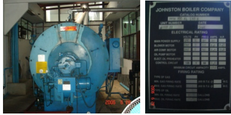
รูปที่ 4.24 หม้อต้มไอน้ำและขนาดพิกัดของหม้อต้มไอน้ำที่ใช้งานในอาคาร
