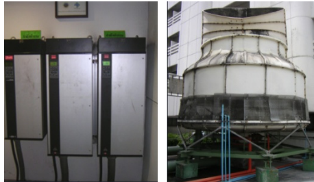
รูปที่ 4.13 การติดตั้งระบบควบคุมความเร็วรอบ (Variable Speed drive : VSD) ของมอเตอร์ระบายความร้อน (Cooling Tower)
