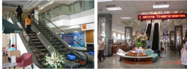
รูปที่ 4.5 การสัญจรภายในโถงและการใช้บันไดเลื่อนซึ่งสามารถควบคุมแบบอัตโนมัติในโถงสูงแผนกผู้ป่วยนอกช่วยสร้างความต่อเนื่องในการใช้งานระหว่างชั้น 1 และชั้น 2
