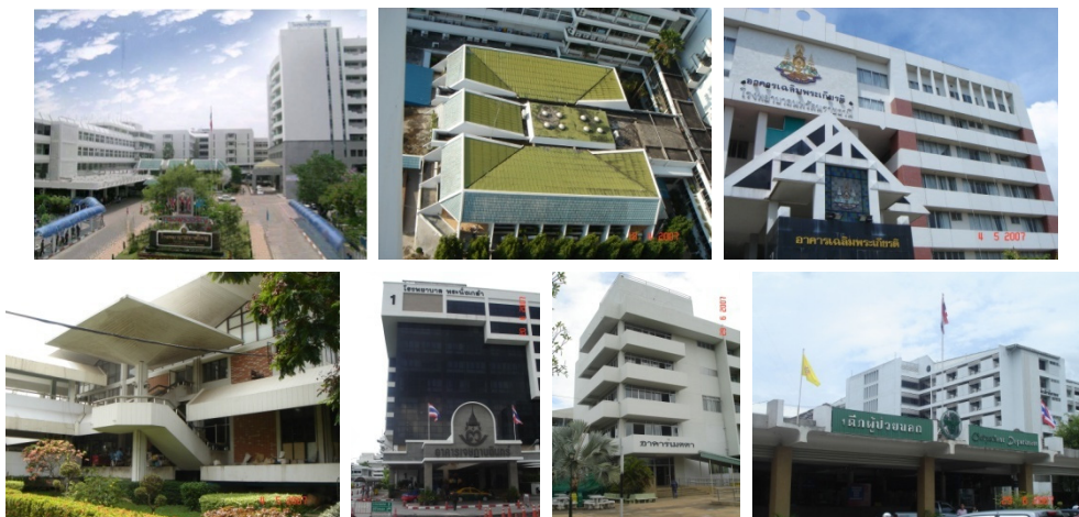
รูปที่ 4.15 แสดงรูปลักษณะของอาคารต่างๆ ในโรงพยาบาลรัฐบาล ที่ประกอบด้วยกลุ่มอาคาร
