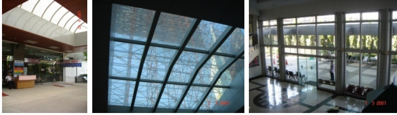
รูปที่ 4.4 การใช้ผนังกระจก Tempered Glass และหลังคาสกายไลท์ (Skylight) บริเวณโถงทางเข้าอาคารแผนกผู้ป่วยนอก (O.P.D.) ชั้นล่าง ที่เอื้อประโยชน์ต่อการรับแสงธรรมชาติ (Day Light) และทำให้พื้นที่ดูโอโลงสบายตา
