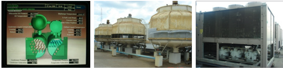
รูปที่ 4.22 หน้าจอรับคำสั่งของเครื่องทำน้ำเย็นและหอระบายความร้อนที่ใช้งานในอาคาร
