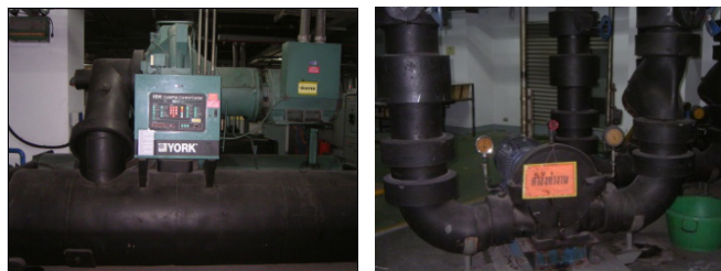
รูปที่ 4.12 ป้อนน้ำเย็นและเครื่องทำน้ำเย็นที่ใช้งานในอาคารโรงพยาบาลเอกชน
