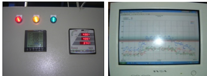
รูปที่ 4.14 การติดตั้งระบบบริหารจัดการพลังงาน และควบคุมการใช้ไฟฟ้า
