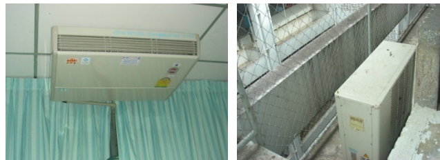
รูปที่ 4.23 เครื่องปรับอากาศแบบแยกส่วน (Split Type) ที่ใช้งานในอาคาร
