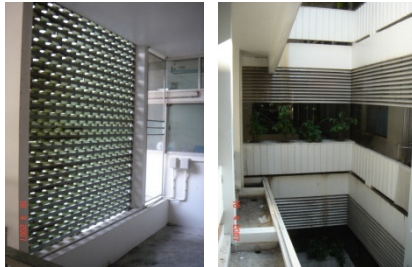
รูปที่ 4.17 แสดงการติดตั้งกระเบื้องบังแดดและแผงบังแดดบริเวณทางเดินของอาคาร
